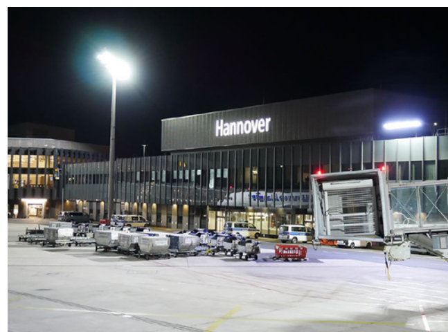
Bedarfsgerecht gesteuerte LED-Beleuchtung auf dem Vorfeld am Hannover Airport – angepasst an den Flugplan
